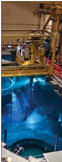
Plataforma de recarga
